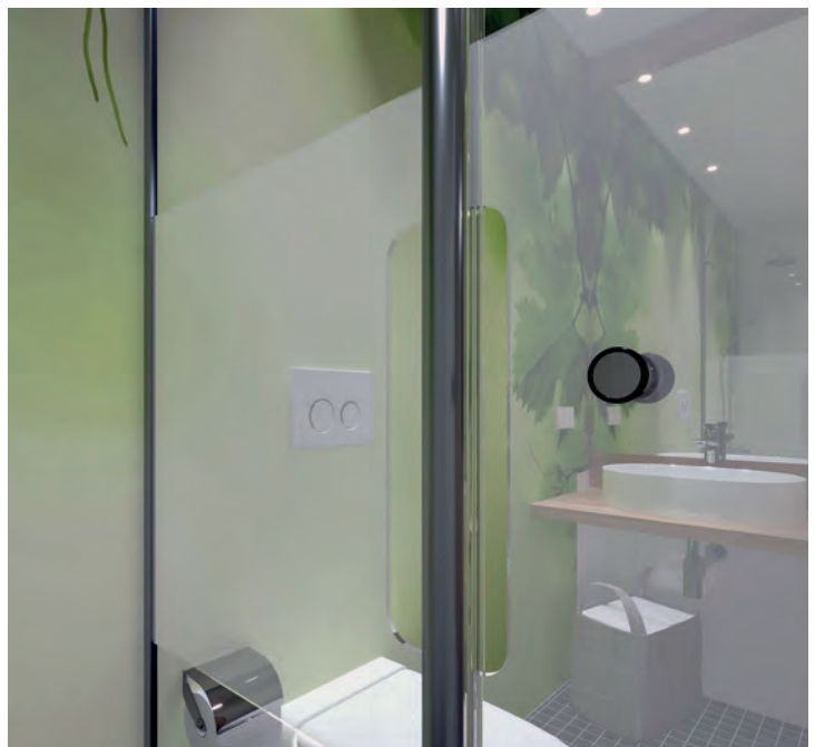
Form folgt Funktion: Die Aussparungen im Glas ermöglichen für Rollstuhlfahrer:innen die Nutzung des Holms als Griff – ein durchdachtes Detail für sichere Selbstständigkeit.
